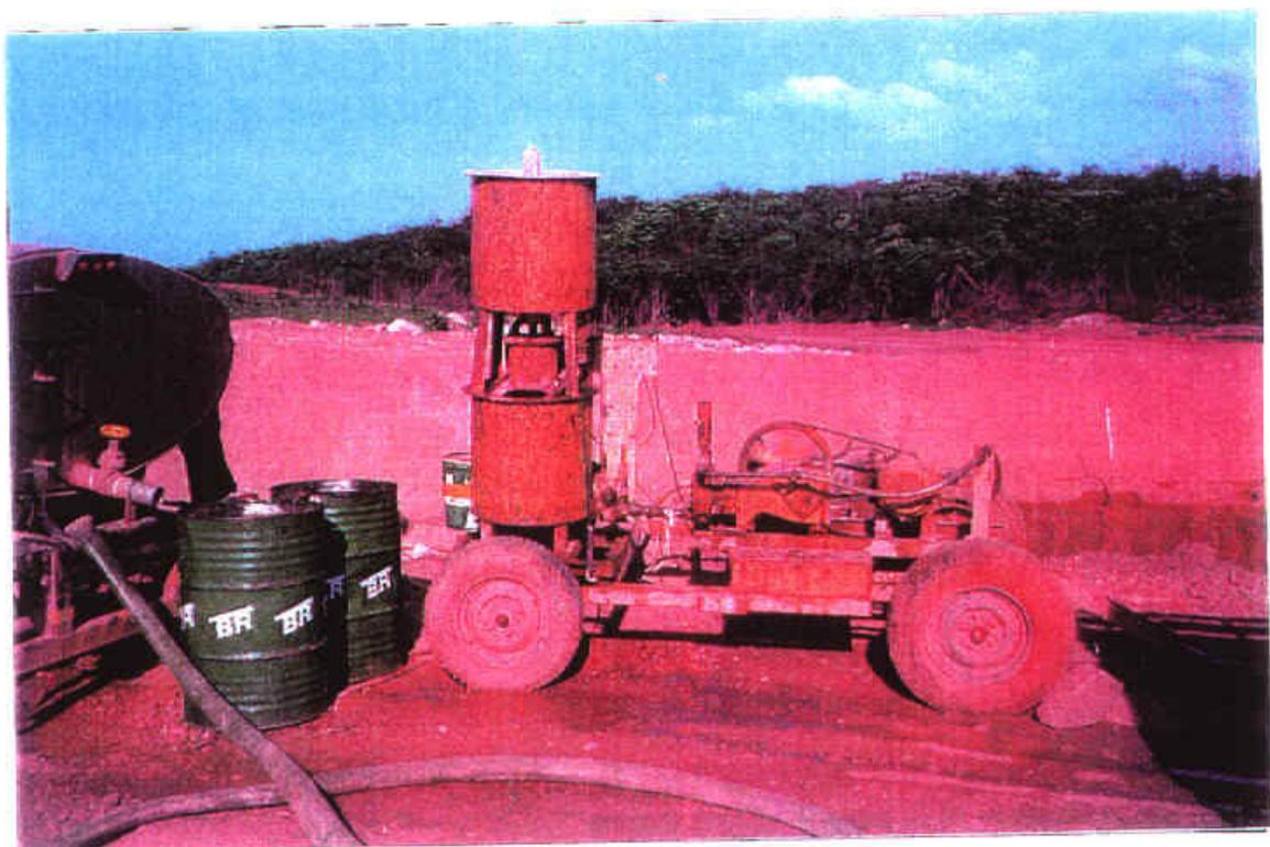
Foto 03 – Equipamento de injeção de cimento na estaca 5.
